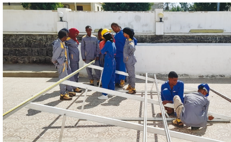
Djibouti : jeunes du centre de formation de l'EPED lors d'une installation électrique fonctionnant grâce à des panneaux solaires.
